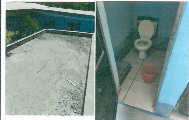
FOTO 4: Reforzar la terraza de los baños por encima.
