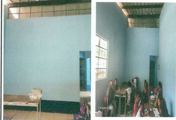
FOTO 2: Ampliación de un módulo
